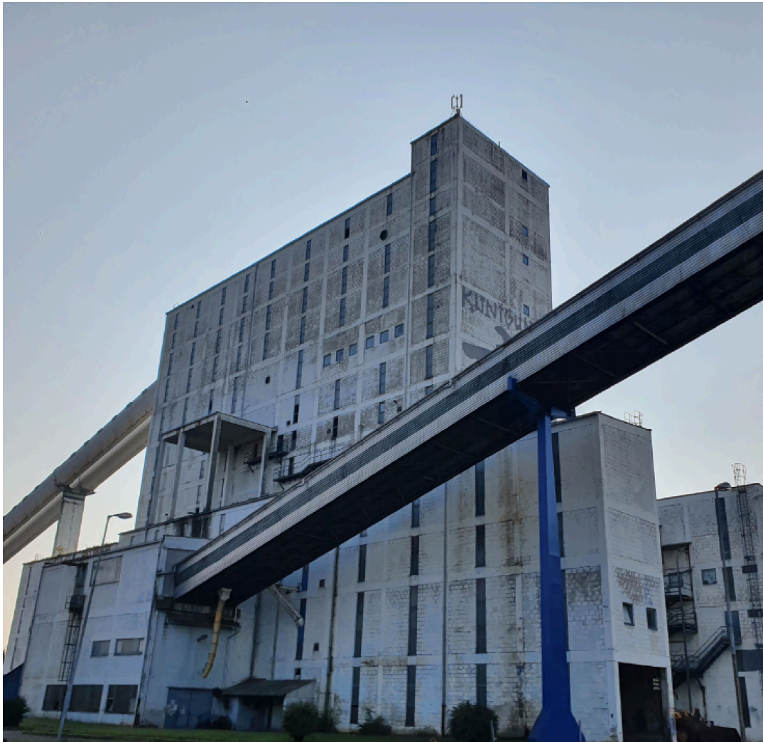
Klasirnica v Velenju je pomembna industrijska dediščina, ki omogoča s svojimi 11.000 m 2 površin umestitev različnih novih dejavnosti. Načrtovana porušitev konstrukcijsko neoporečne stavbe bi prinesla 38.000 ton gradbenih odpadkov in uničenje dediščine, zato je nedopustna. Foto: Gaja Žgank.
